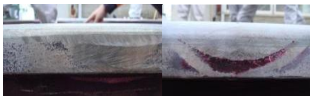
(a) 外観検査 (b) 浸透探傷検査
