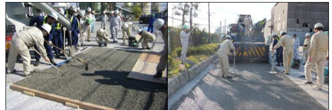
写真-1 施工状況（左：人力施工 右：機械施工）
