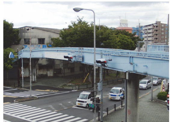
写真-1 対象とした歩道橋
