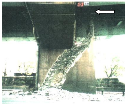
図-4 橋脚 神 240(北面) 11)
