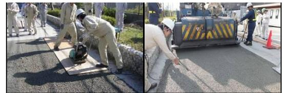
写真-1 人力施工および機械施工状況
