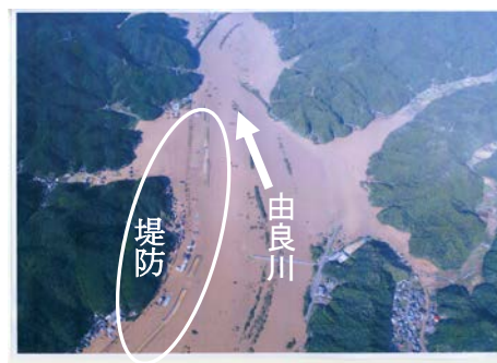
写真 1 浸水状況と堤防 (国交通省福知山提供)
