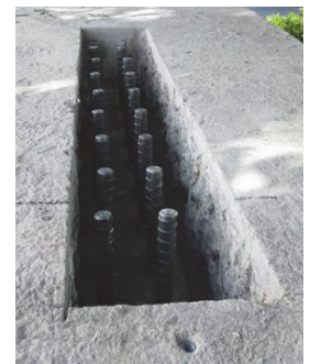
図-3 ずれ止めの溶接
