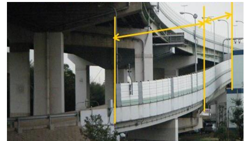
Fig.1 対象橋梁 外観
