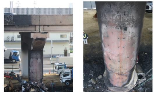
写真-1 橋脚の被害状況の一例
