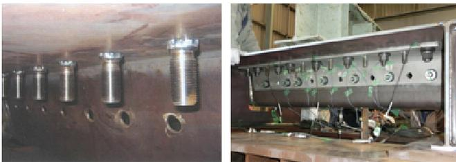
図-1 鋼床版の補修補強用いるスタッドボルト
