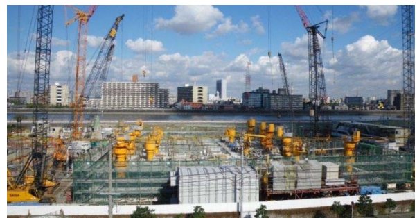
写真-1 施工全景
