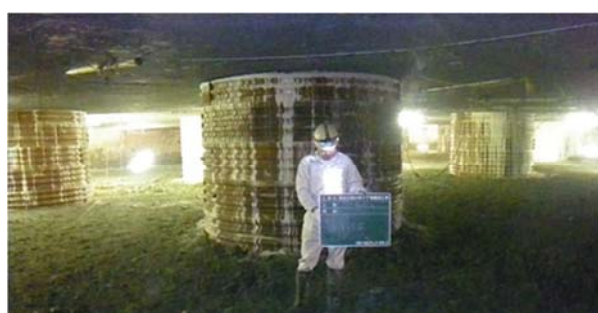
写真-2 支柱の造成状況
