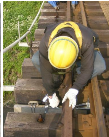
写真-5 改善した取付方法
