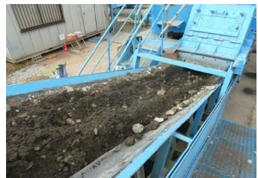
図 3 現場で混合処理された土
