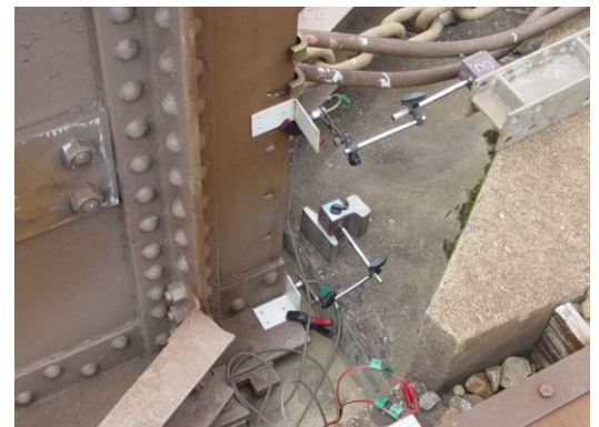
図 1. 桁端の水平変位の計測状況
