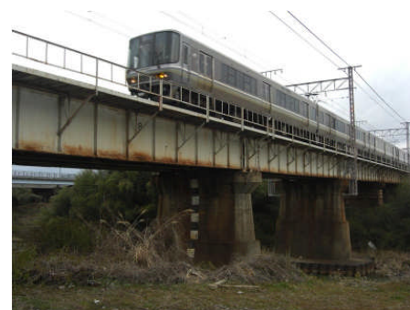
図-6 橋マクラギ式上路鉄道橋の一例
