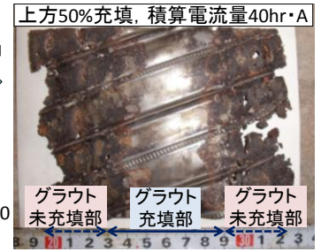
図-7 シースの腐食状況の一例(シーソ外側)
