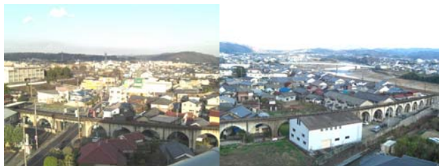
写真-1 新町高架橋と五條市中心部
