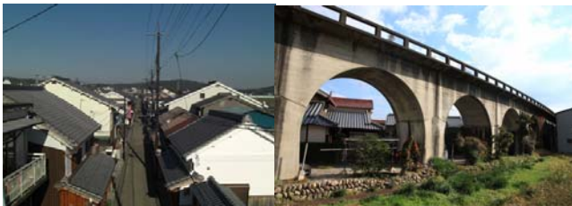
写真-4 新町通りの俯瞰及び新町高架橋の外観
