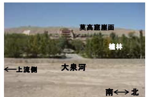
写真1 東正面から見た莫高窟全景 表1 含浸塩量の試験パターン
