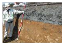
写真-2 天端舗装部
