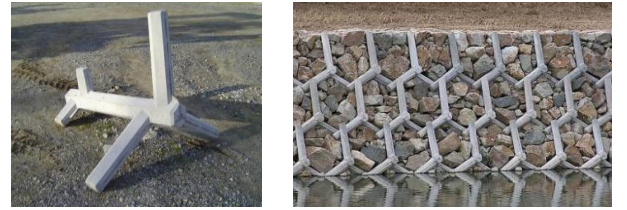
写真1 ブランチブロック 1) 写真2 施工例（出石川） 1)
