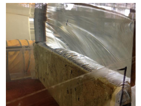
写真-1 剥離現象
