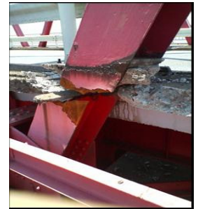
図 1 斜材の破断
