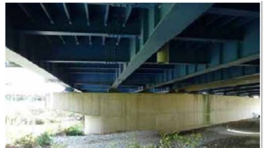
図-1 古江橋の概況
