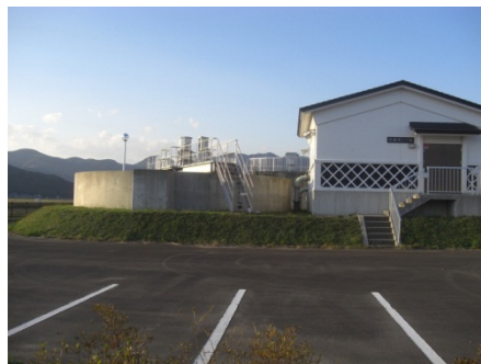
写真-2 北上浄化センター 外観
