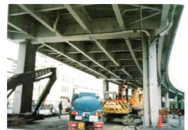
写真-3 高速道路の二本柱区間の代表的構造
