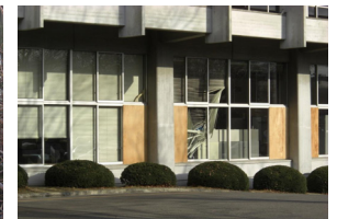
写真 2 市役所の被害
