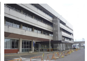
写真 4 市役所の被害
