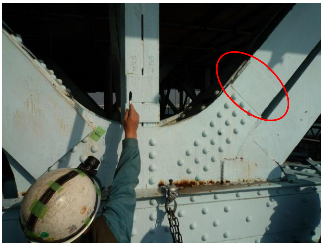
写真 1. 実橋斜材突合せ状況
