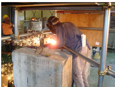
写真3 溶接状況（溶接②）
