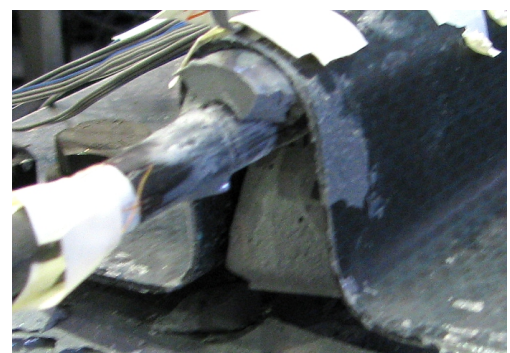
図－8 ロッド引き抜け後の様子
