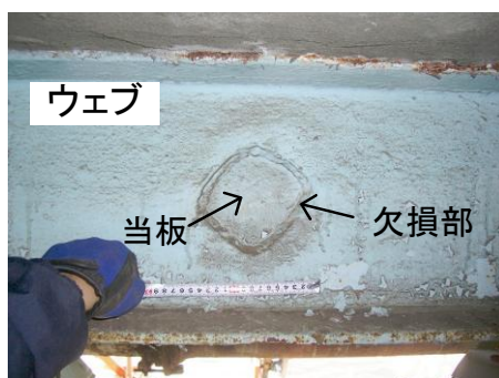
写真 1. 実物のウェブの当板溶接補修部(表側)
