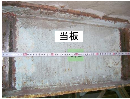
写真 3. 実物のウェブの当板溶接補修部(裏側)
