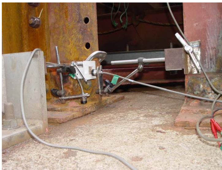
写真2. 桁下端付近の計測装置取り付け状況
