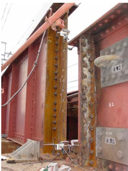
写真1. 桁端水平変位計測状況
