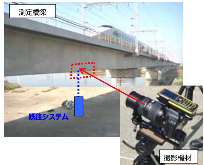
図 3 対象橋梁と撮影機材
