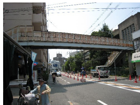
写真-1 歩道橋全景
