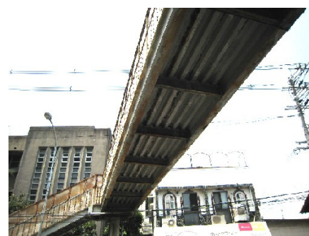
写真-2 桁下面の状況
