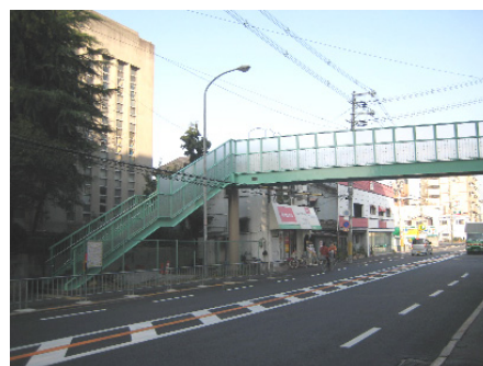
写真-4 竣工後の現況
