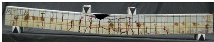
写真 3 M 供試体 (通電期間 12 日)
