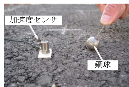
写真-1 衝撃弾性波法の計測状況
