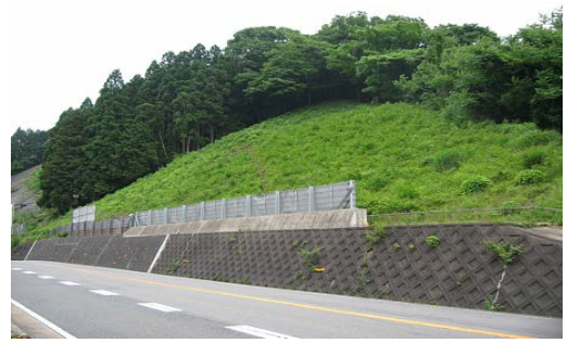
図-6 B 地区現場写真
