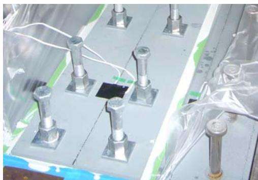
写真-1 低鋼板継手部のスタッド取り付け状況
