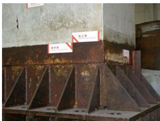
写真-1 橋脚基部のき裂と三角リブと防護板
