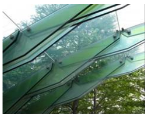
図 - 1 ガラス支持構造物
