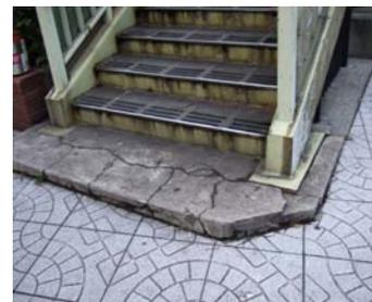
写真-1 階段基礎の破損
