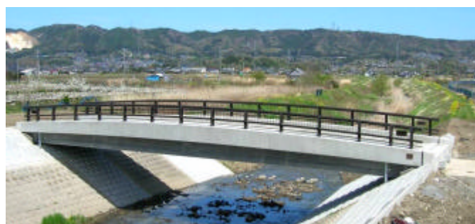
写真3. 低桁高橋の施工例（豆飼橋、橋長26m）
