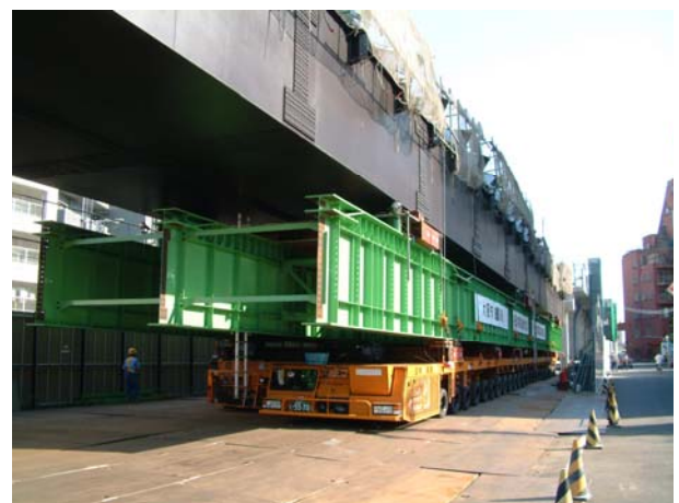
写真-1 重量物運搬台車上の中央径間
