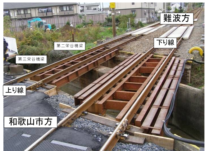
写真－1 橋梁全景 (南海本線栄谷第三, 第二橋梁)
