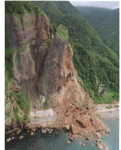
図1 斜面の写真(崩壊後) 1)
