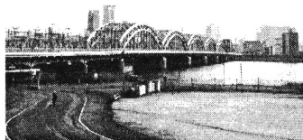
写真-7 橋梁02の既設状態
