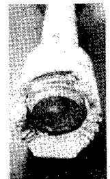
写真-2 変断面スタッドの疲労破壊場所
