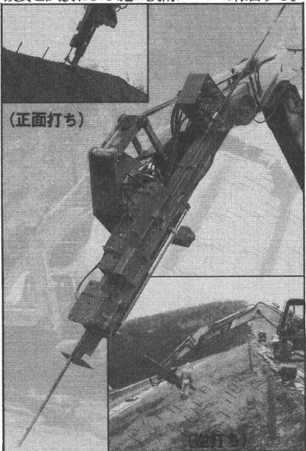
写真-1. ショベル先端に取り付けられた急速鉄筋打設機と使用例
