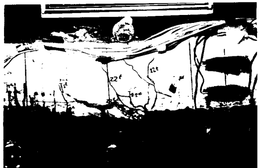
写真-2. 引張側補強の場合の破壊状況
