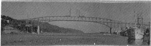
写真-1. 閉合完了の境水道橋
