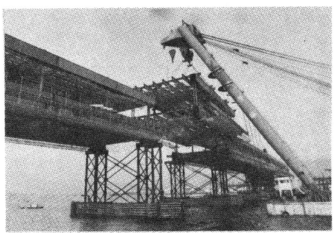
写真-1 上下弦材最終ブロックの架設
